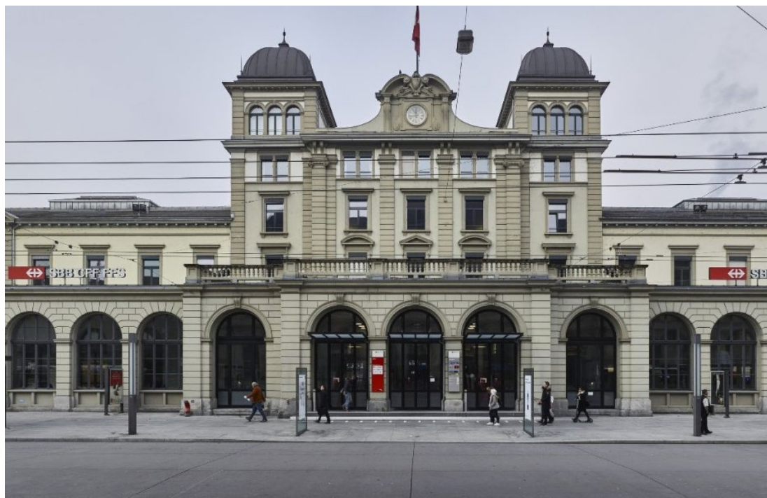
SBB Bahnhof Winterthur
